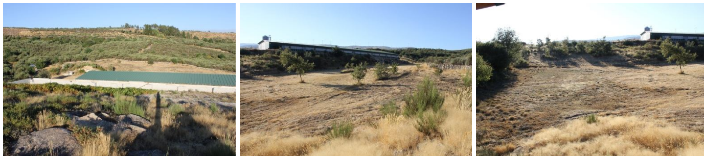
Foto 17: Vista geral da base do terreno junto à linha de água
