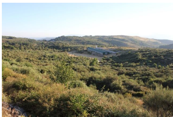
Foto 15: Vista geral da área de implementação do projecto
