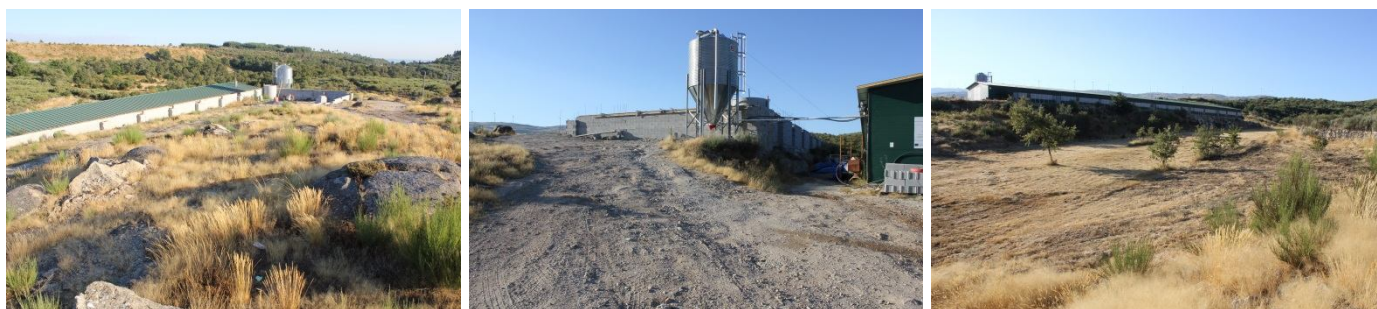
Foto 18: Vista geral da área urbanizada
